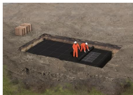
Obrázek 13: Zakrytí geotextilií
