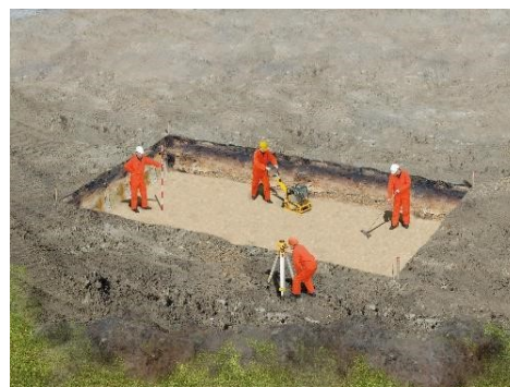
Obrázek 7: Příprava vyrovnaného základu
